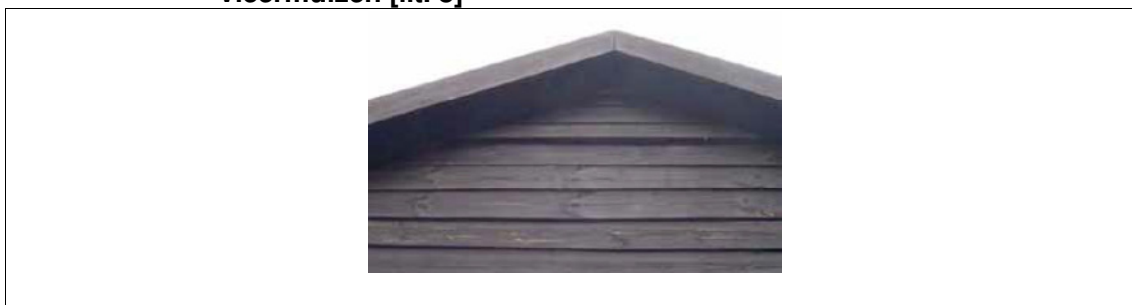
Afbeelding 7.3. Voorbeeld gevelbetimmering geschikt verblijfplaats gewone dwergvleermuizen [lit. 8]
