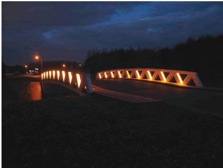
Beperkt en amberkleurig verlichten ivm vleermuizen
