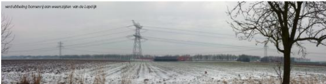
Zicht vanaf Achterdijk bij verdubbeling bomenrij Lapdijk
