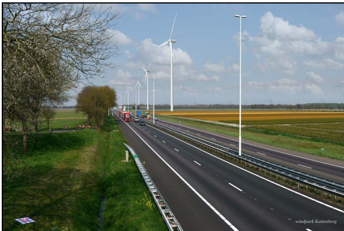
Fotopunt C, 480 meter van dichtstbijzijnde turbine
