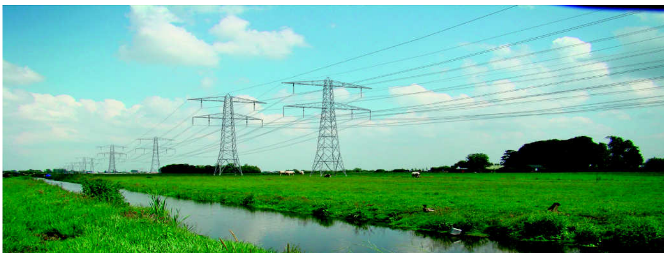
Afbeelding 4.2 Twee - circuits vakwerkmast gebundeld met twee - circuits vakwerkmast
