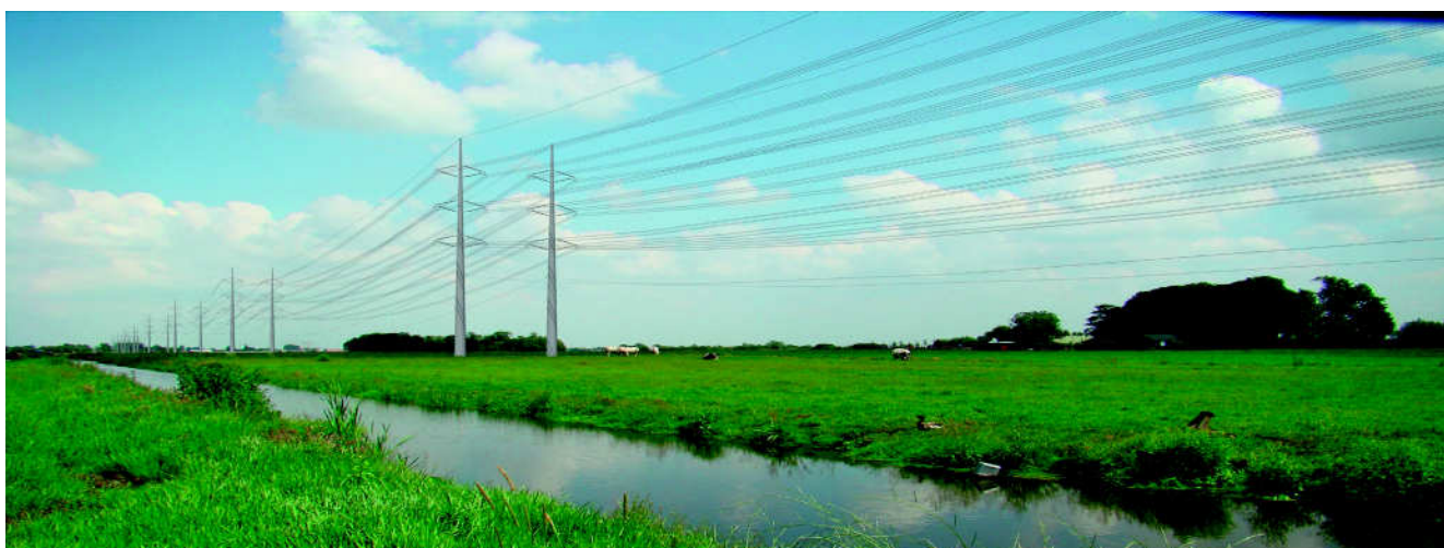
Afbeelding 4.1 Een gecombineerde vier - circuits Bipole-mast
