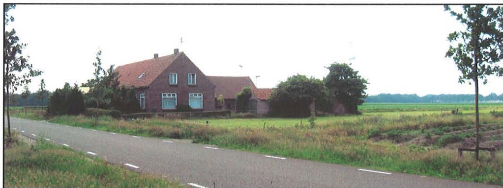
fig. 2: Zijaanzicht van de huidige te slopen boerderij
