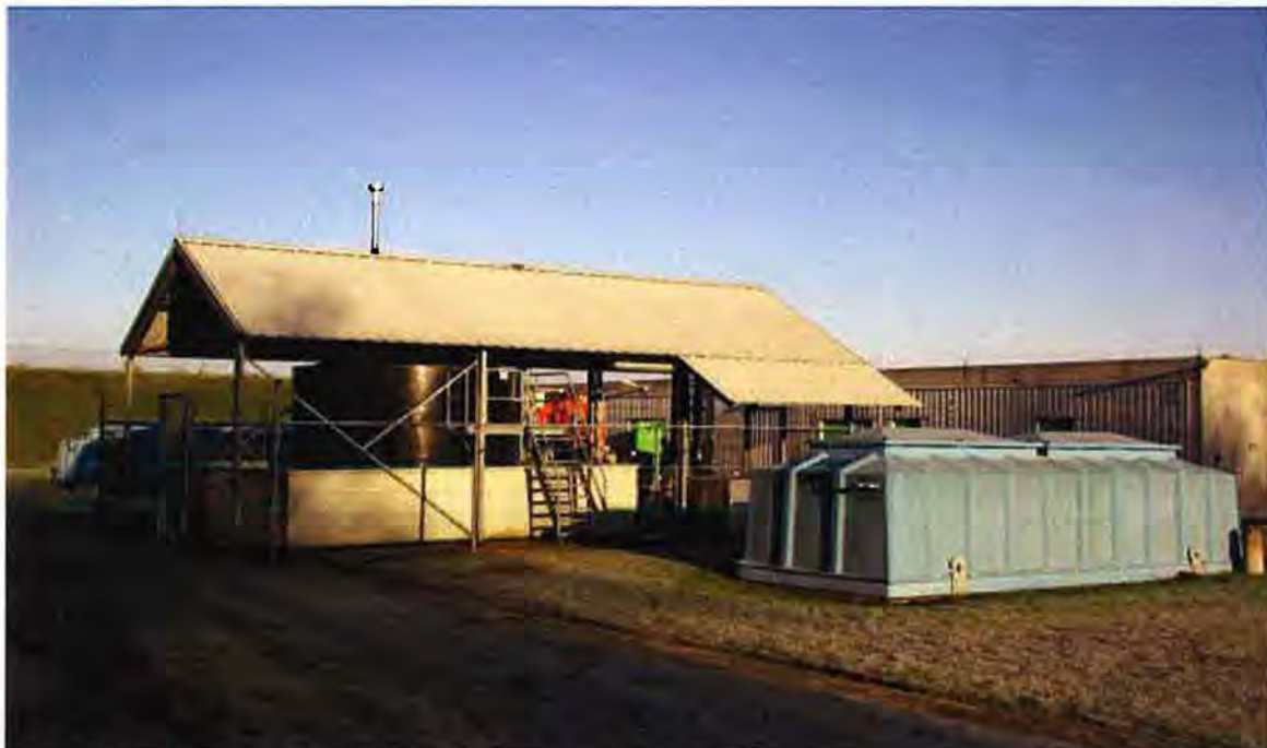
figuur 2 biologische voorzuivering methanol opslag
