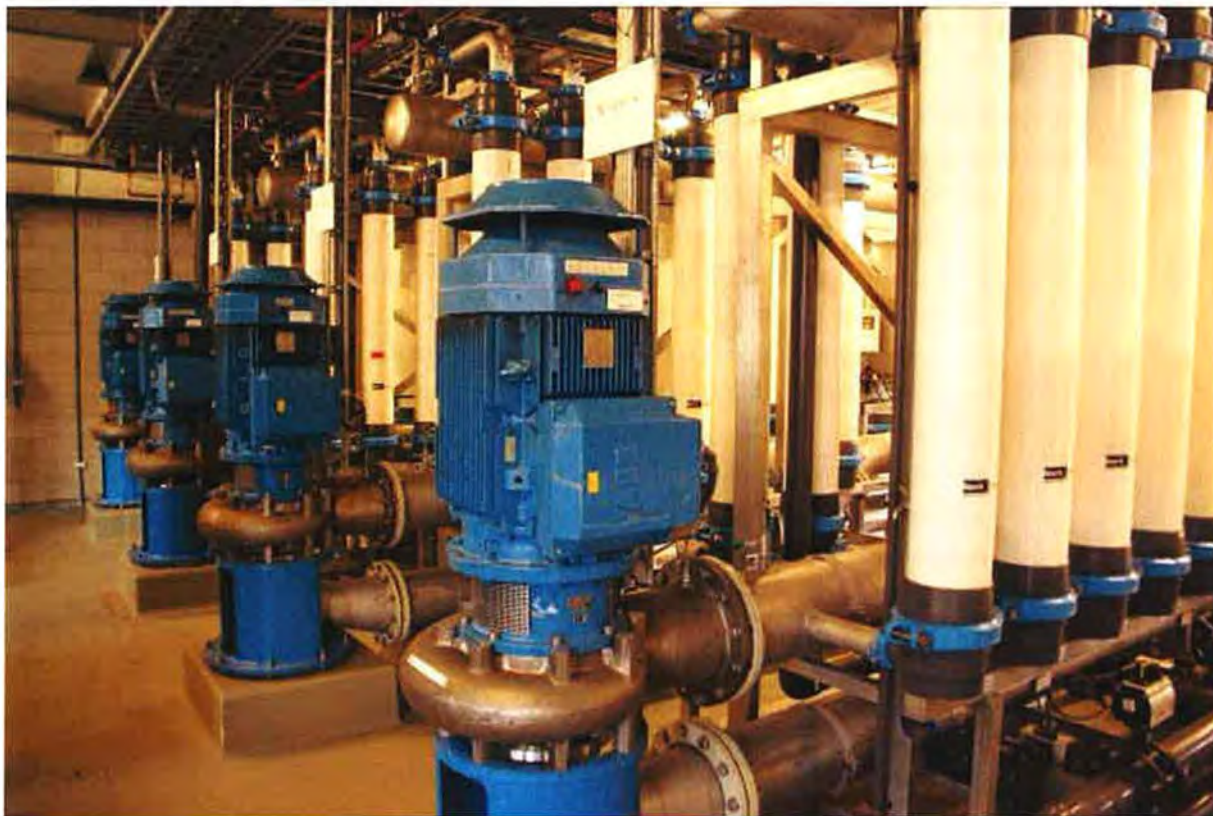
figuur 1 nano filtratie inst. GWZI
