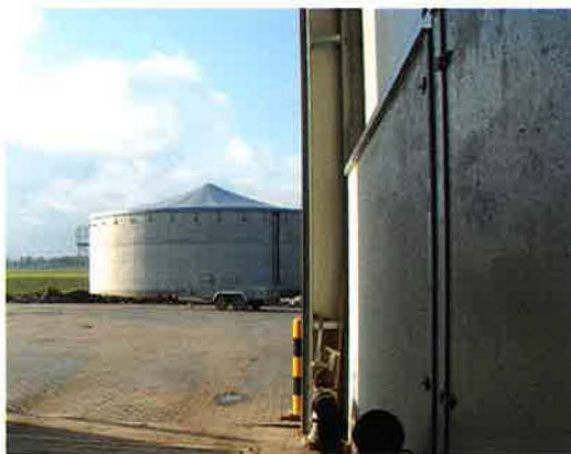
Betonnen mestsilo's met puntdak
