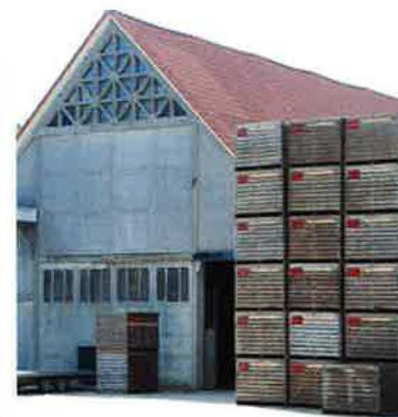
Prefab betonnen gevels
