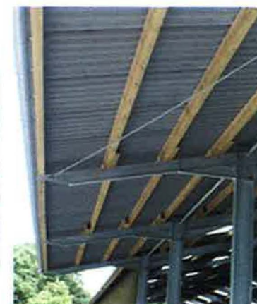
Daken met overstek
