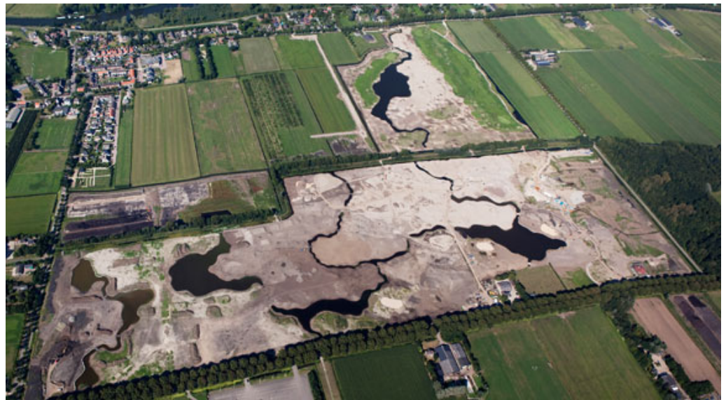
Luchtfoto aanleg golfbaan The Dutch Noordbaan [www.thedutch.nl, augustus 2009]
