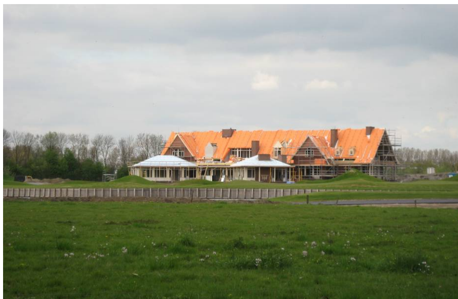
Figuur 4.7 Golfpaviljoen The Dutch Noordbaan in aanbouw [april, 2010]
