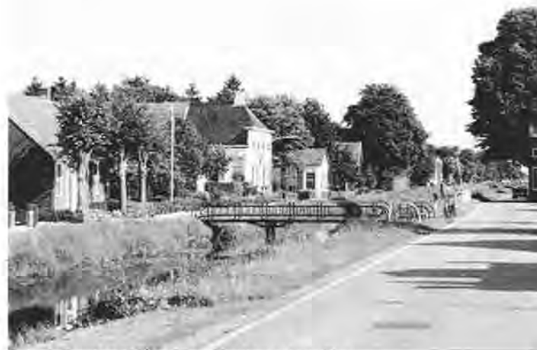
Foto 2.1 Aanzicht bebouwing langs het diep
