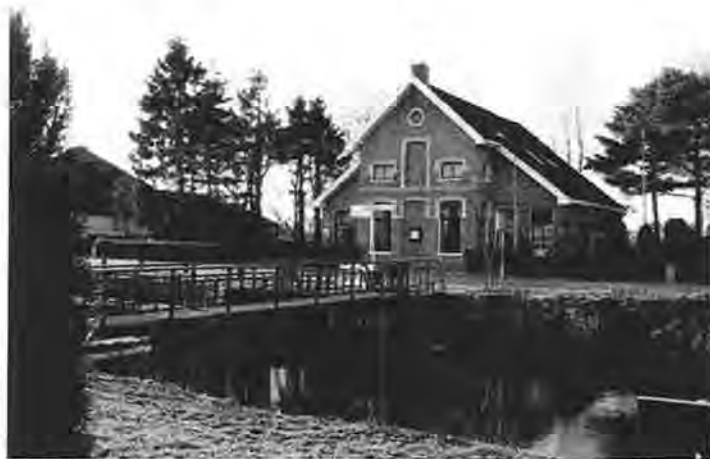
Foto 3.3 Sluiswachterswoning aan de Sluisweg
