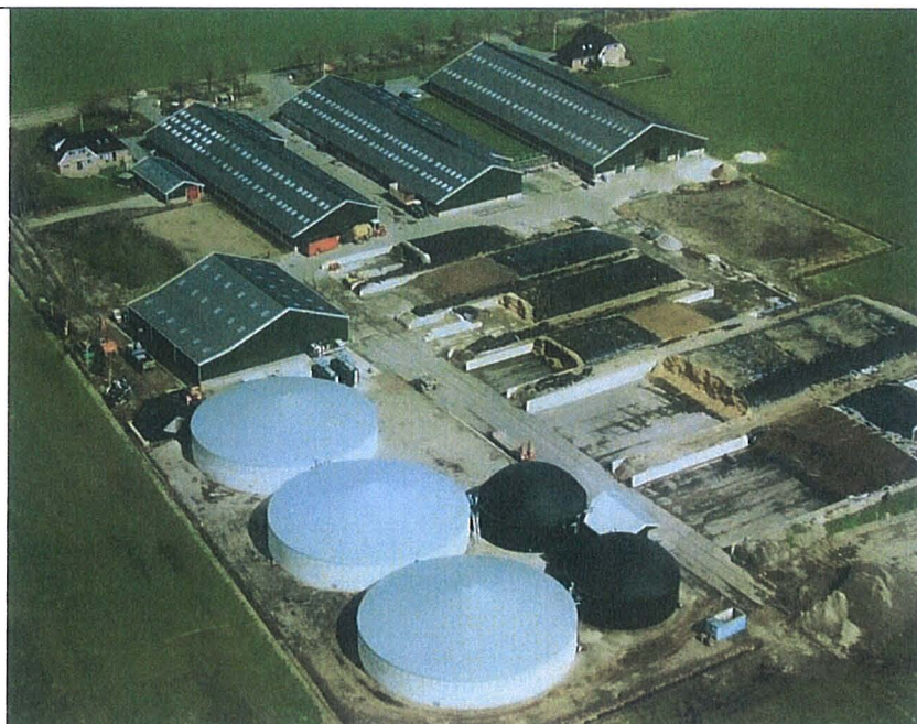
Vergistingsinstallatie op boerderijschaal; www.hoSt.nl
