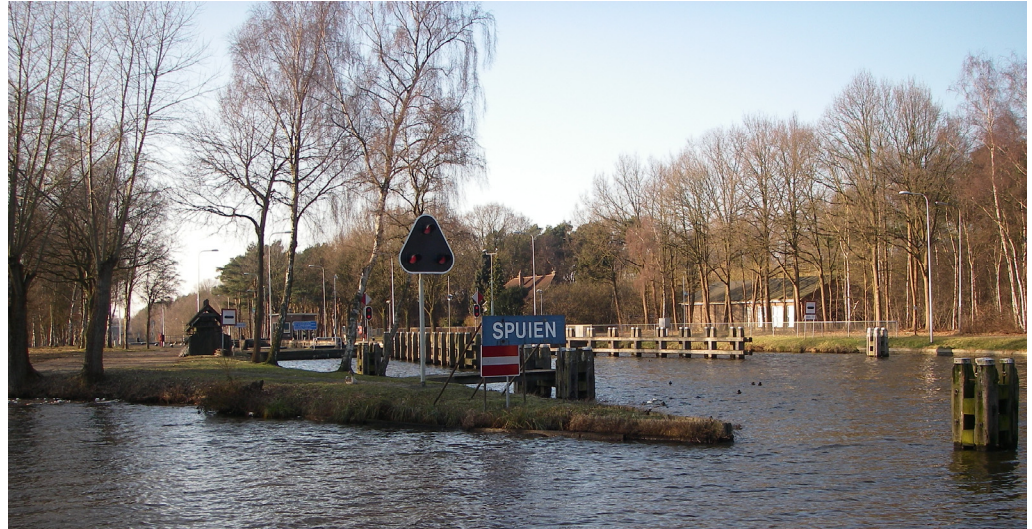
Figuur 5.2 Sluis III, gezien vanuit het oosten.
