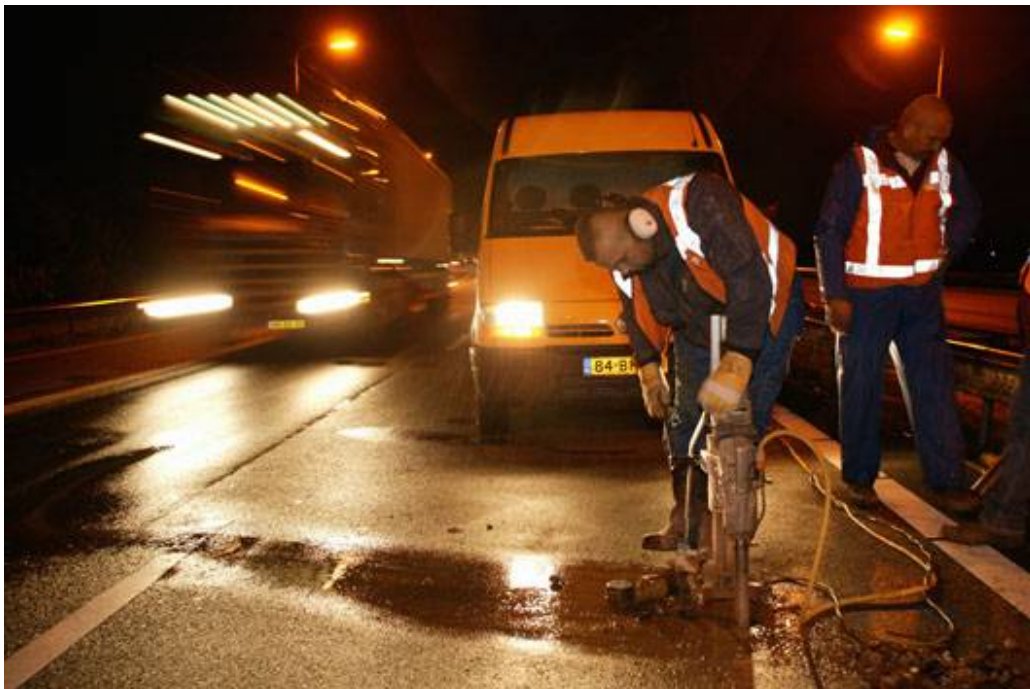
Figuur 7.10,1: Voorbereiding voor sondering onder het wegdek van de Prins Mauritssingel ten behoeve van project Ruimte voor de Waal
