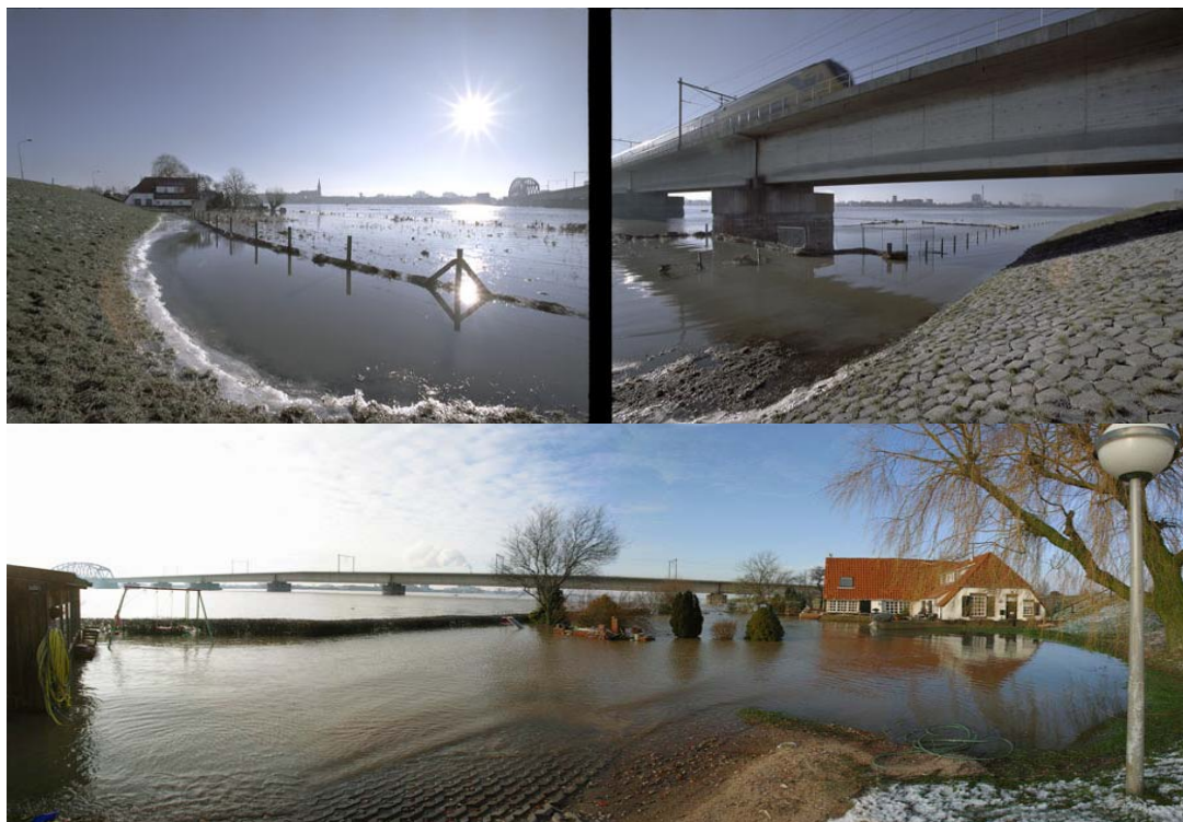
Figuur 2.2: Zicht op spoorbrug vanuit Veur-Lent in een situatie met overstroomd winterbed
