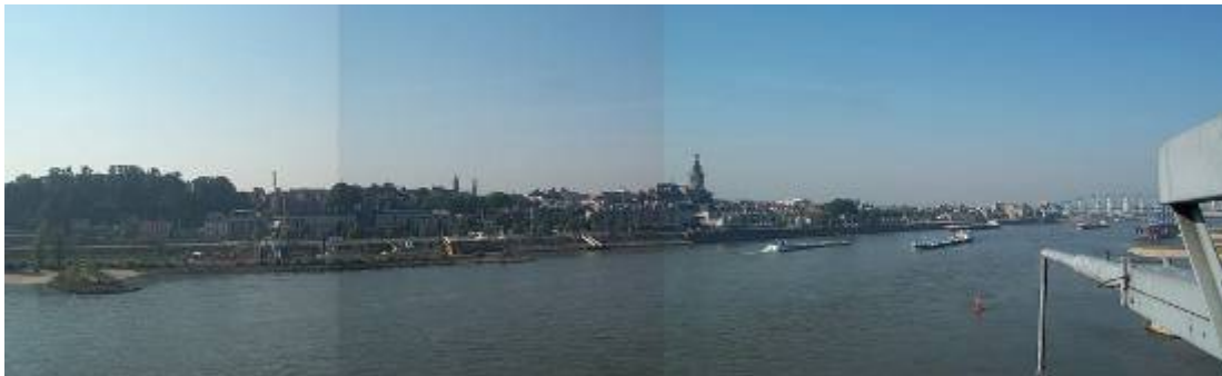
Figuur 3.24: Nijmegen – Waalkade, gezien vanaf Waalbrug (foto 2004, MER 2005)
