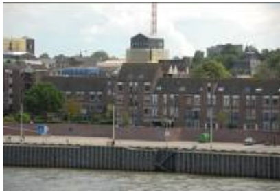
Figuur 3.25: Nieuwbouw de Hessenberg (hier nog gedeeltelijk in de steigers in de zomer van 2009), markante toevoegingen aan het silhouet van het stadscentrum
