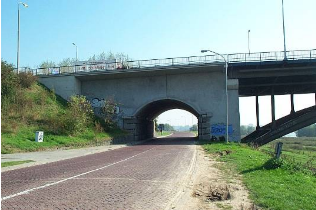
Figuur 3.10: Bruggenhoofd van de Waalbrug
