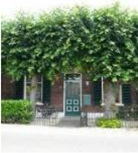
Woning in dijklint
