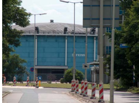
Figuur 6.3 Gashouder Ferro
