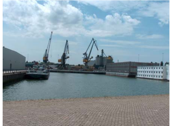
Figuur 4.10 Detentieboot Merwehaven
