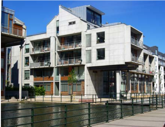
Figuur 14 Water opgestuwd
