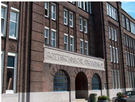
Figuur 6.5 Kantoorgebouw RDM
