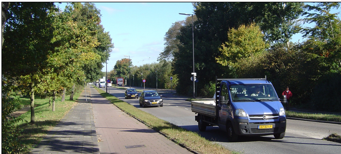
Figuur 4.14 Foto: Breed en groen profiel van de Marathonweg. Fietspad en trottoir zijn gescheiden van de rijbaan door middel van groenstroken
