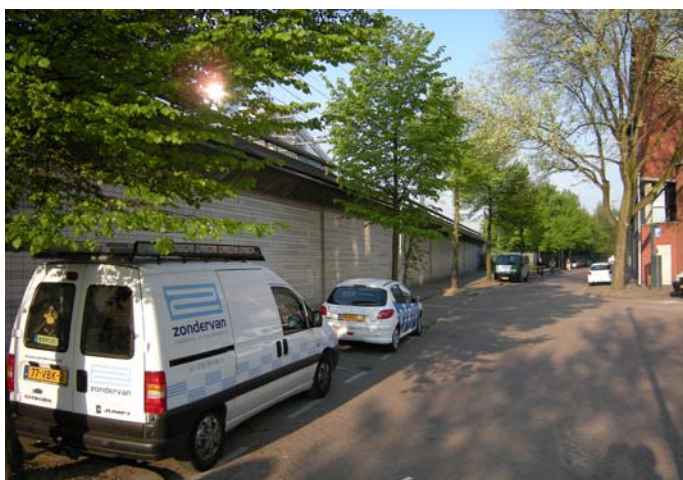
Talud noorzijde (Molenwaterweg)
