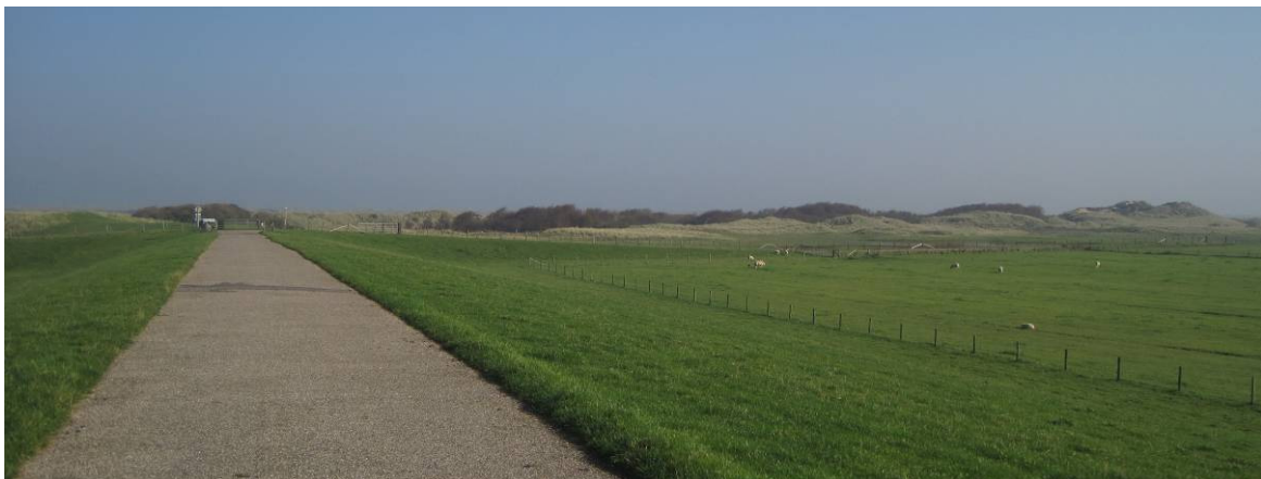
Einde van de Waddendijk aan de uiterste oostkant bij dijkvak 7, waar er aansluiting is op de Kooидуinen en de Kooigrie. Op de achtergrond de Kooiduinen en rechts de buitendijks gelegen begraasde kwelder, onderdeel van het Natura-2000 gebied Waddenzee. Gezien vanaf de dijk, september 2011 (foto A&W).
