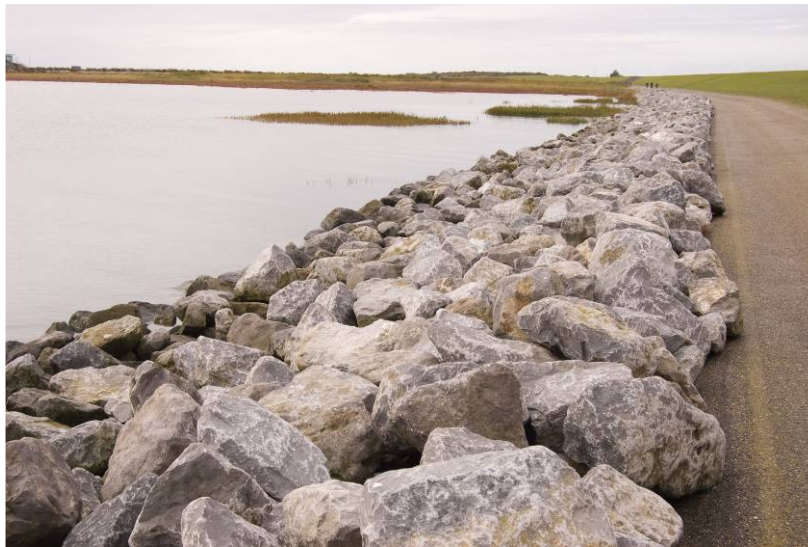
Afbeelding 3.7. Illustratie overlagen losse breuksteen
