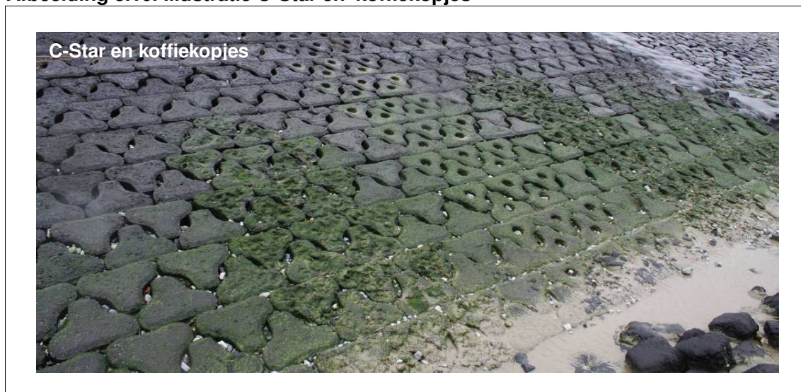
Afbeelding 3.10. Illustratie C-Star en 'koffiekopjes'
