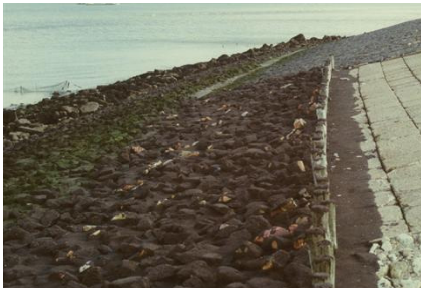
Afbeelding 3.8. Illustratie overlagen gepenetreerde breuksteen
