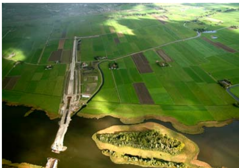
De Hanzelijn in aanleg en het gebied van de toekomstige bypass
