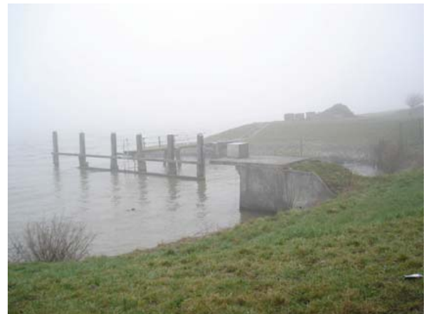
Figuur 7.14 Aanlegsteiger bij gemaal Loudon
