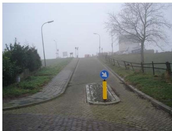
Figuur 7.16 Opgang dijk bij Wieldrecht
