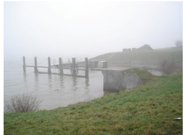
Figuur 4.12 Aanlegsteiger bij gemaal Loudon
