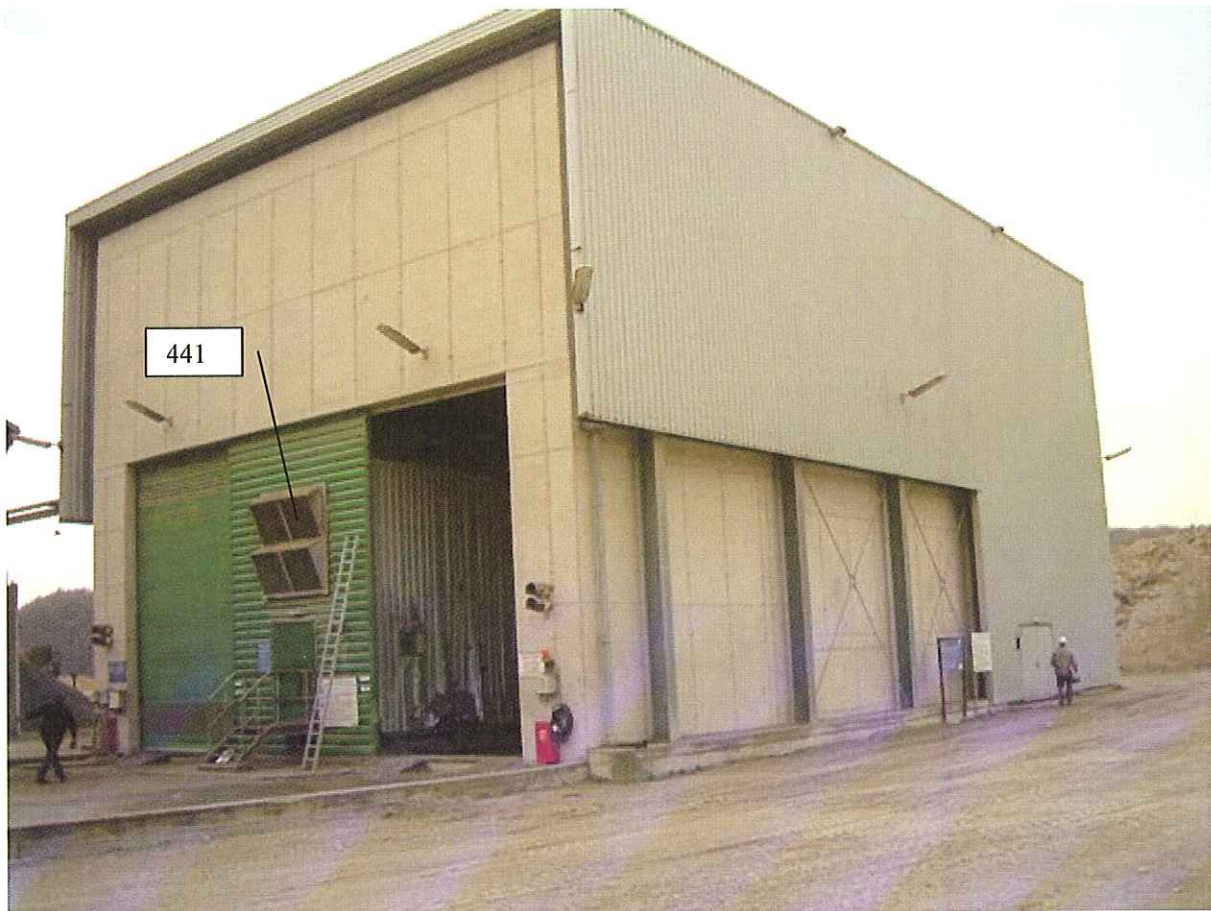
Bron 441: ventilatie westgevel SBI
