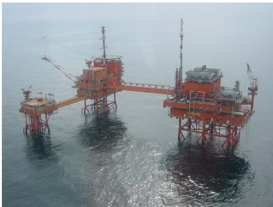
Figuur S3 Foto van het bestaande behandelingsplatform P15 C/D.
