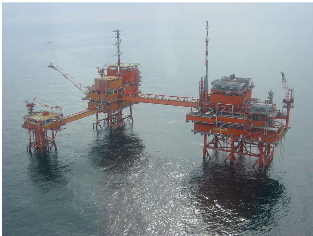
Figuur 4.2 Foto van het bestaande behandelingsplatform P 15 C/D.
