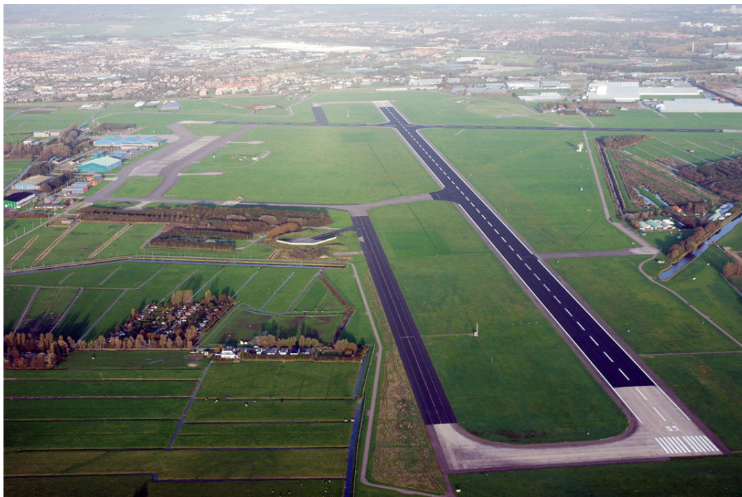
Figuur 1.1: Locatie Valkenburg, huidige situatie
