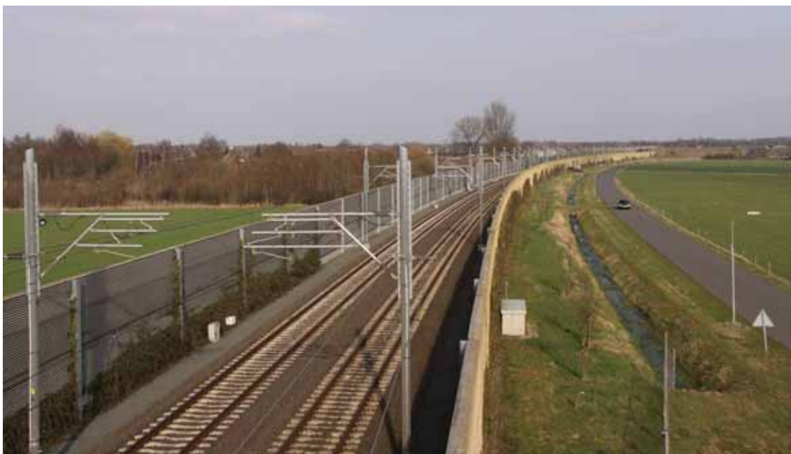
Afbeelding 5-1 Doorsnijding van het landschap door de Betuweroute
