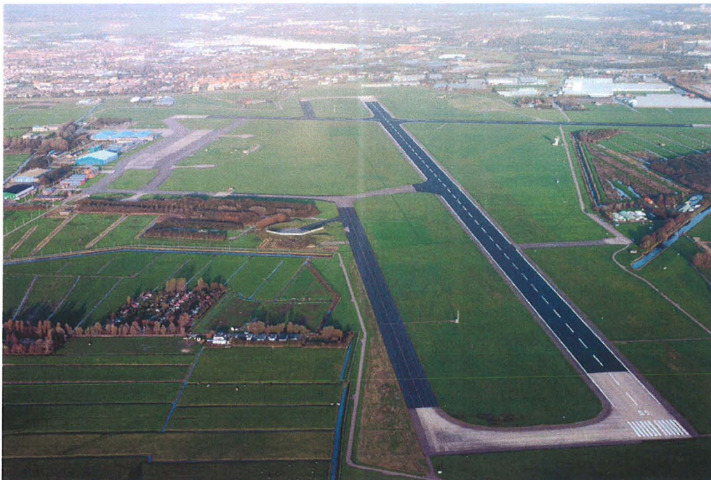
Figuur 1.1: Locatie Valkenburg, huidige situatie
