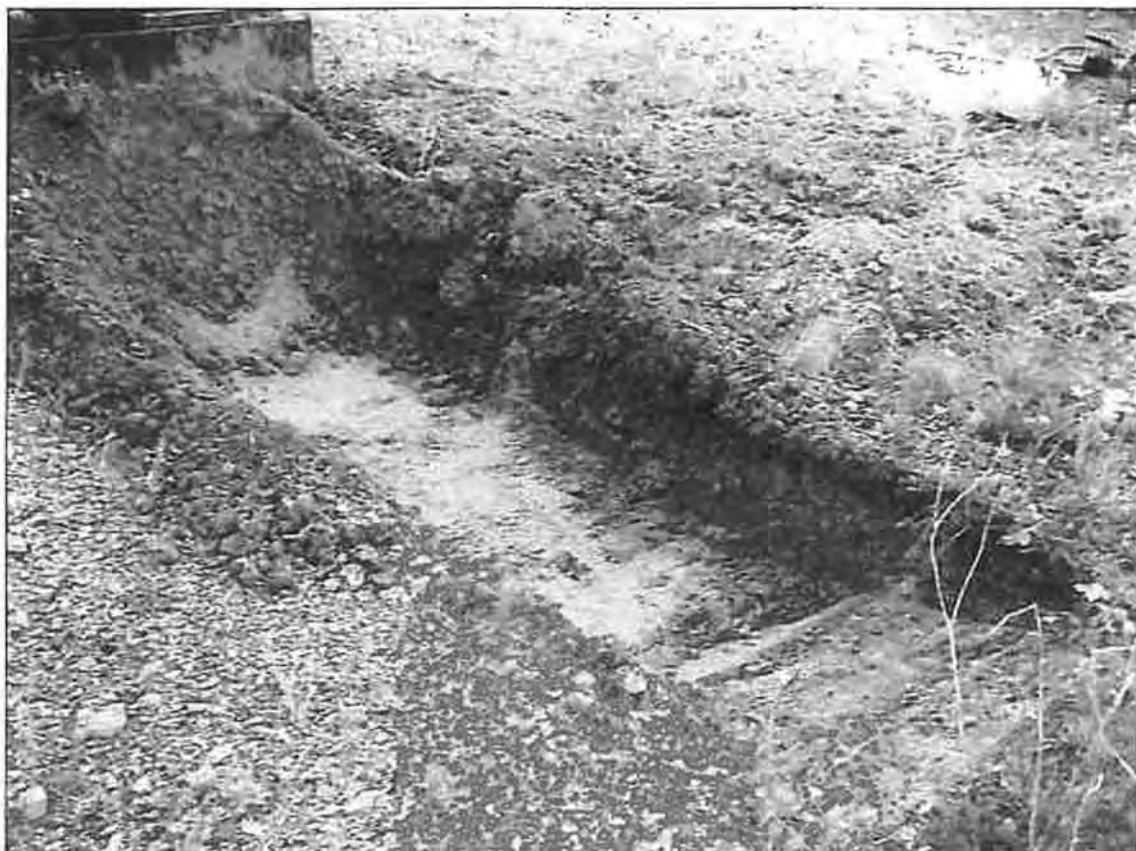
P2008-2426 Asbestonderzoek Overdiemenseweg te Diemen, Foto 11 (d.d. 7-10-2008)
