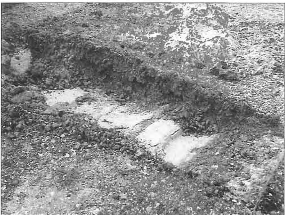
P2008-2426 Asbestonderzoek Overdiemenseweg te Diemen, Foto 8 (d.d. 7-10-2008)
