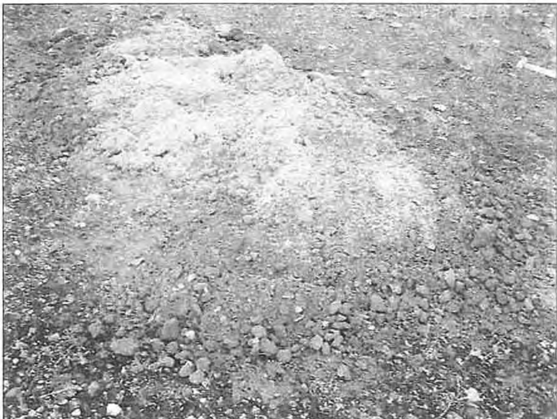
P2008-2426 Asbestonderzoek Overdiemenseweg te Diemen, Foto 4 (d.d. 7-10-2008)
