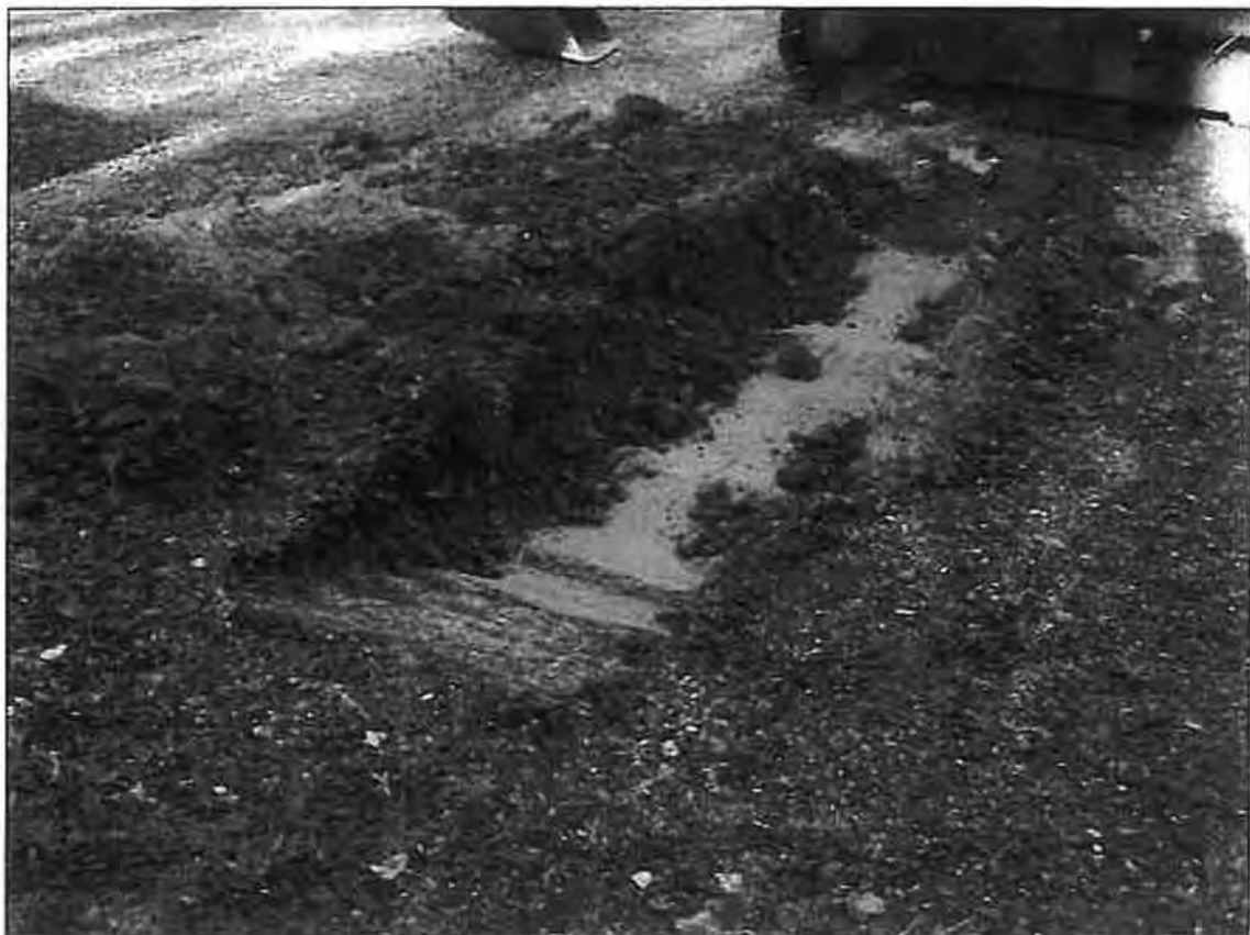
P2008-2426 Asbestonderzoek Overdiemenseweg te Diemen, Foto 7 (d.d. 7-10-2008)
