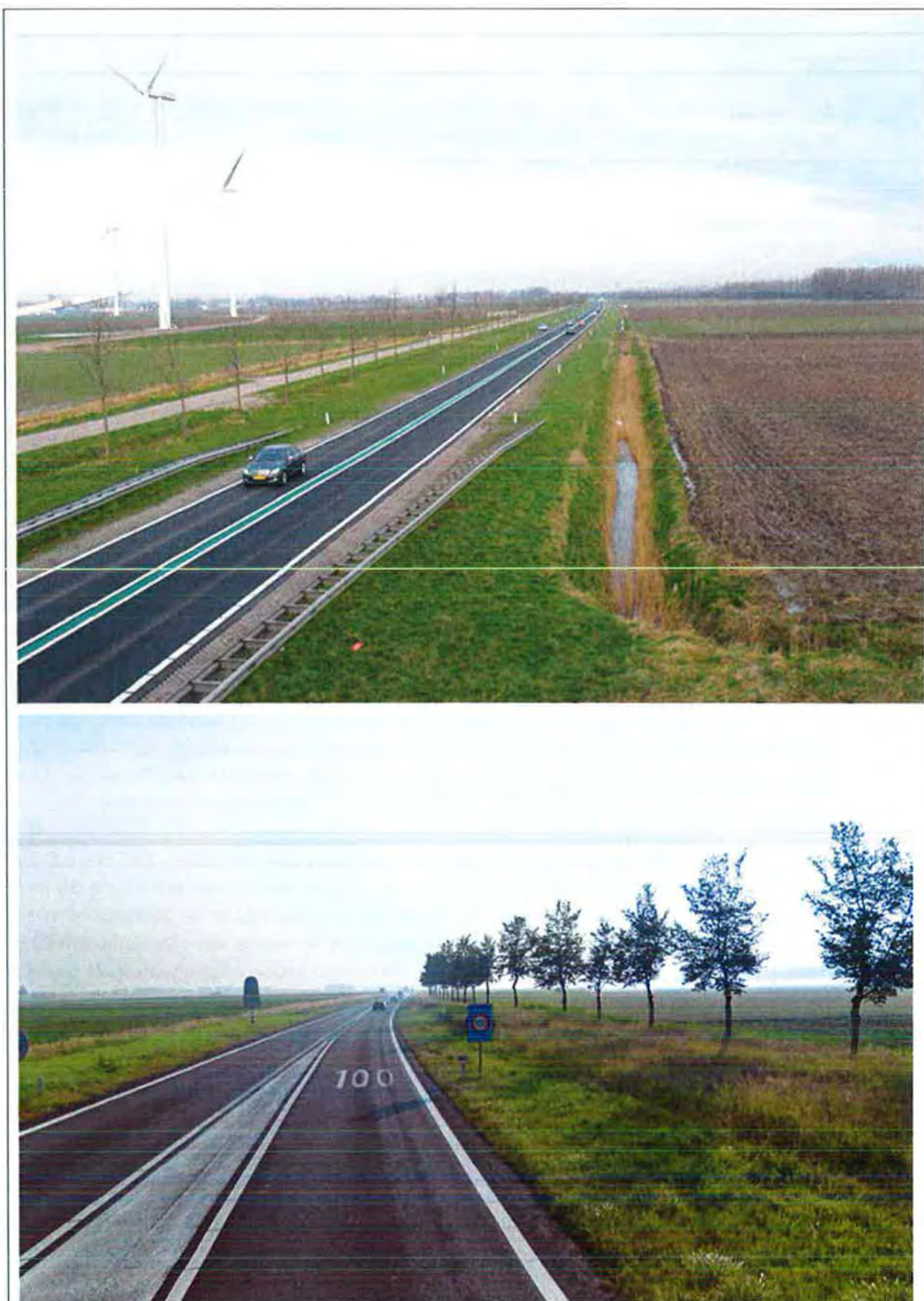
Figuur 4: Foto's bestaande situatie
