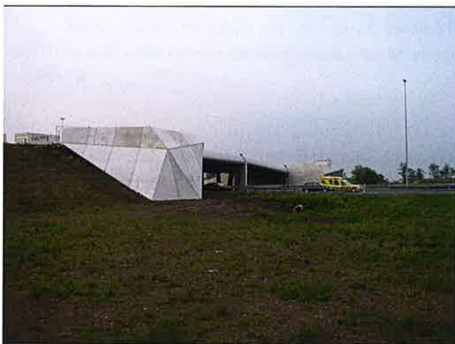
Figuur 11.9 Voorbeeld van een coupure, de Diefdijk. (onderdeel van de Nieuwe Hollandse Waterlinie, bron; Panoramio.com)
