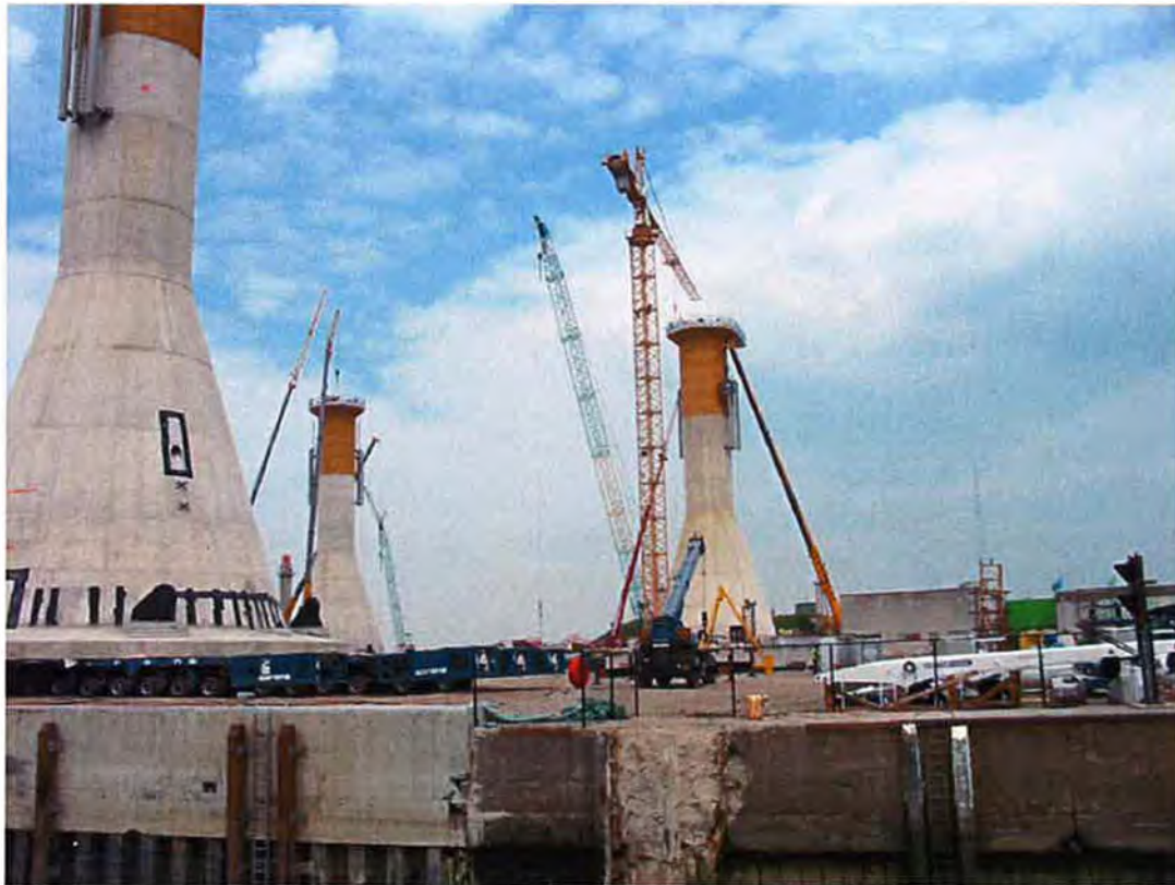
Figuur 3.4 Transport van GBS-funderingen op land ten behoeve van Thorntonbank voor de kust van Oostende (bron: KEMA)
