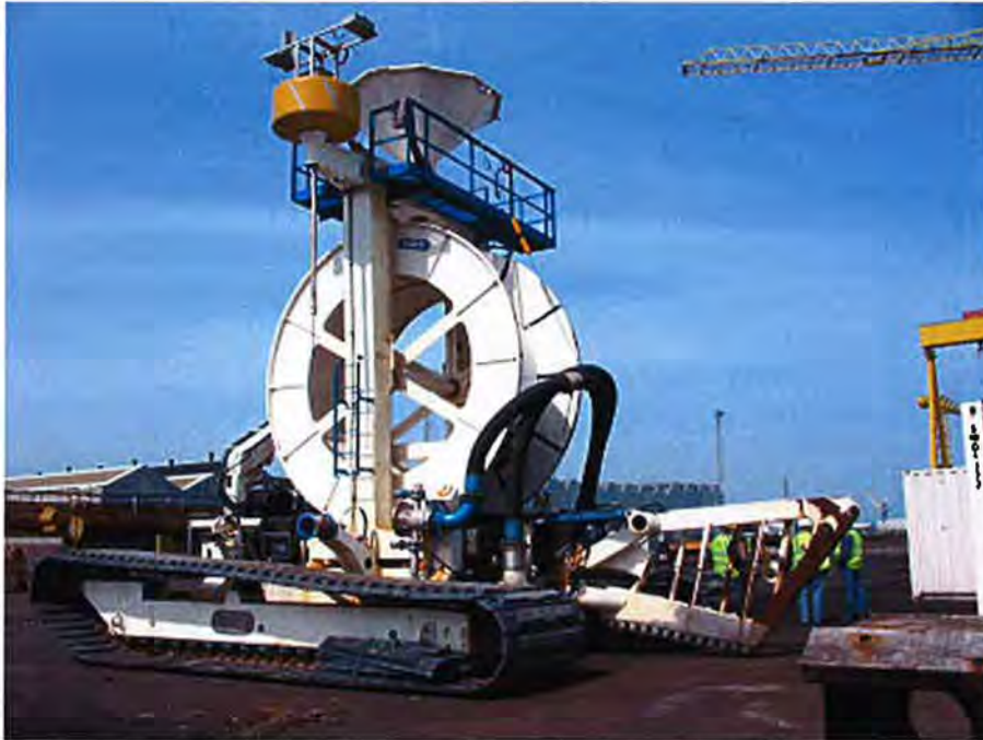
Figuur 3.12 Vaartuig voor het leggen van de kabels in ondiep water
