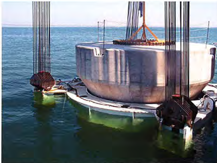
Figuur 3.7 GBS-fundering tijdens de installatie. De fundering laat men langzaam naar de zeebodem zakken, die voor dit doel voorbereid is met een horizontale laag stenen (C-Powerproject, bron: NIRAS)
