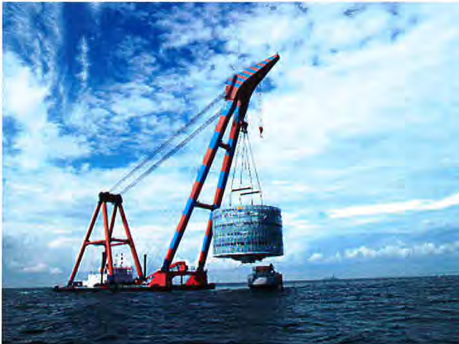
Figuur 3.17 Installatie van het transformatorstation (bron: NIRAS)
