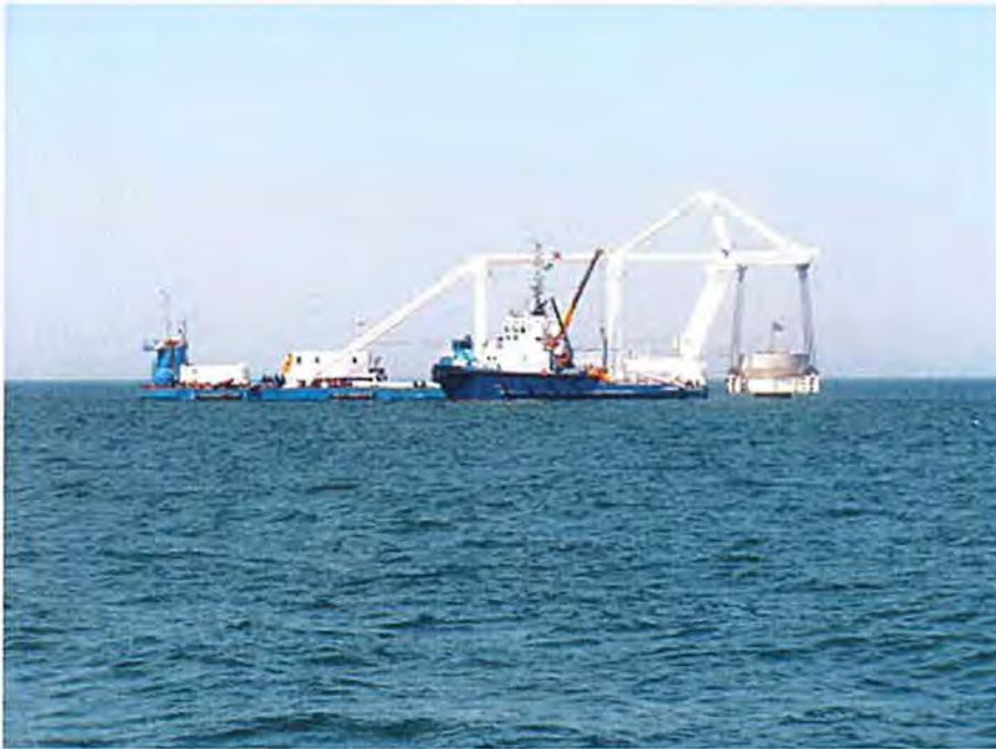
Figuur 3.6 Drijvende kraan met sleepboot, gebruikt voor het plaatsen van GBS-fundering in het C-Powerproject (bron: NIRAS)
