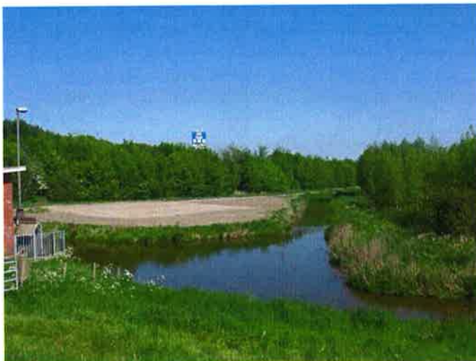
Bestaande afwateringssloot langs Rijksweg A7 (links gemaal Booneschans)
