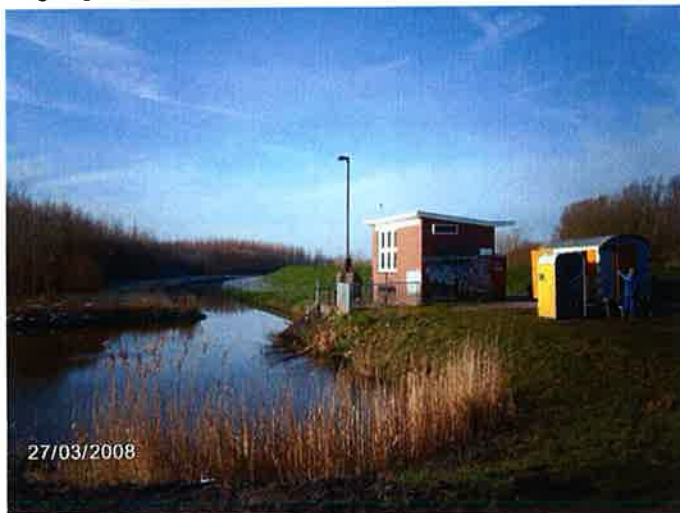
Bestaand gemaal Booneschans
