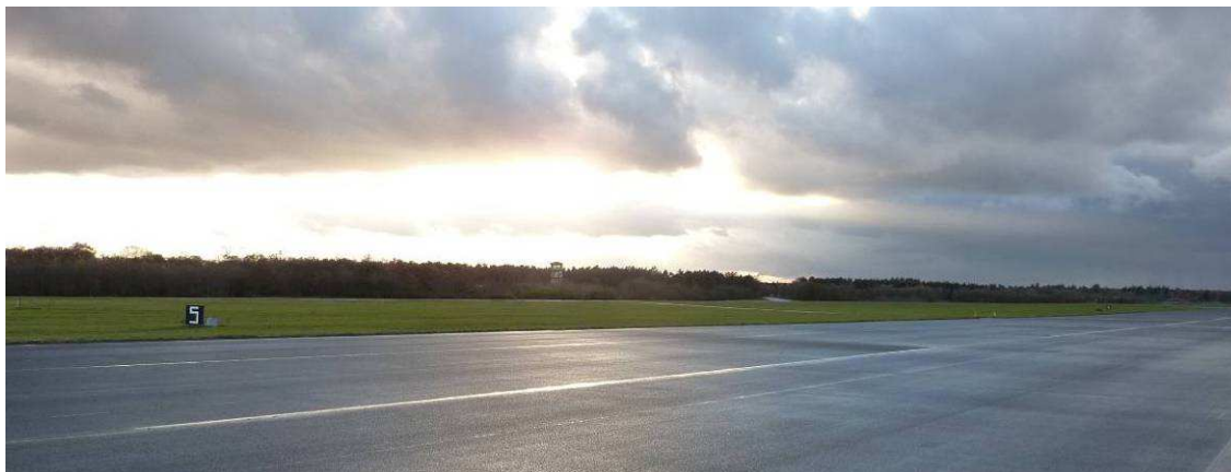
Figuur 6. Zichtpunt 1, bestaande situatie
