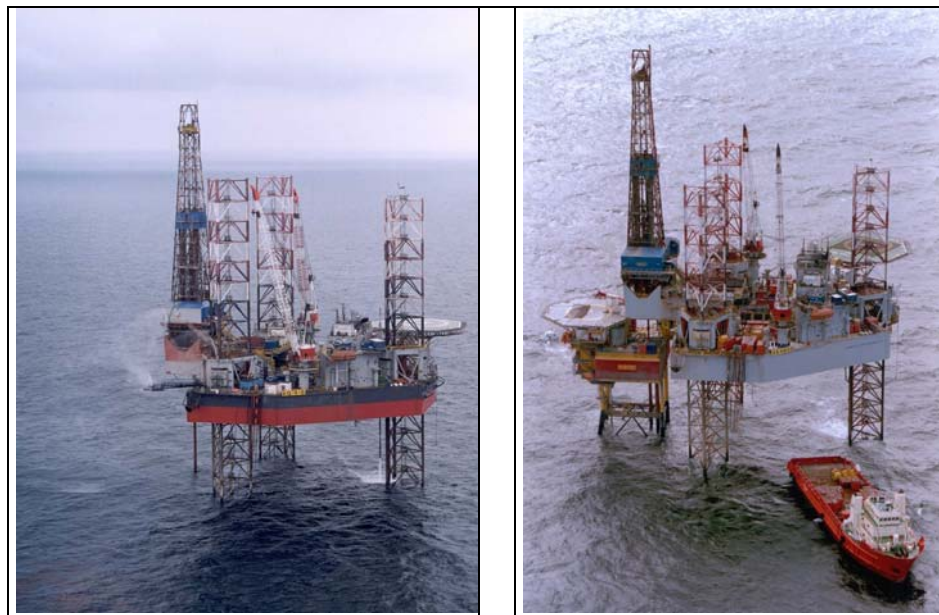
Figuur 4 Boorplatform (links vrijstaand en rechts tijdens boring bij satellietplatform).
