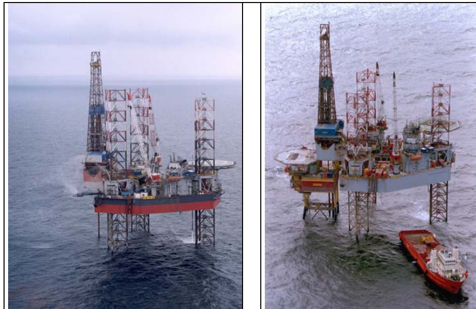
Figuur 4.5 Boorplatform (links vrijstaand en rechts tijdens boring bij satellietplatform)
