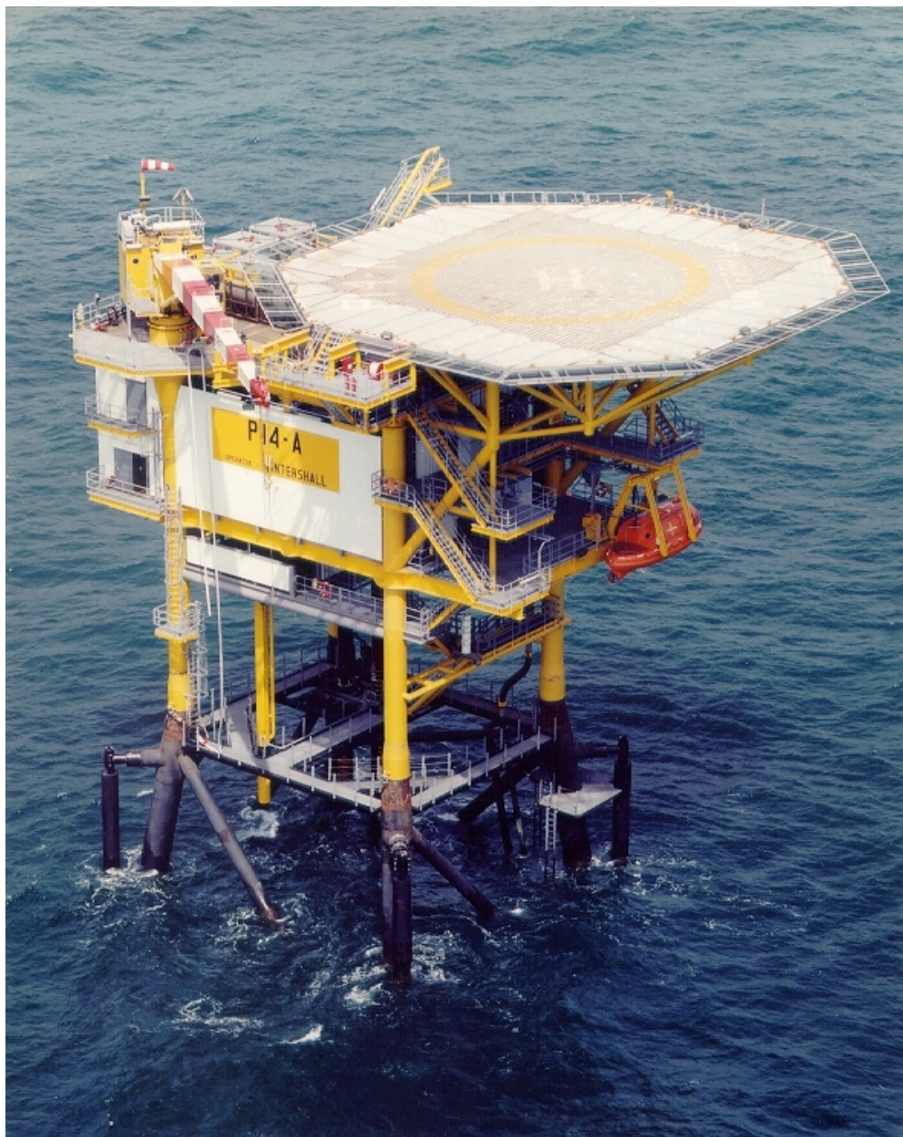
Figuur 3 Platform vergelijkbaar met platform E18-A
