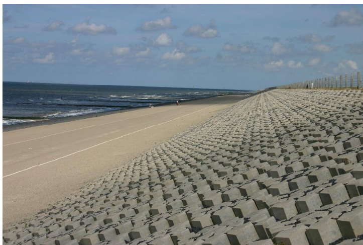
Foto 3.1. Buitentalud Hondsbossche Zeewering met golfoploop remmende blokken
