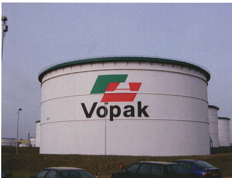
Figuur 3.1.: Voorbeeld van een opslagtank
