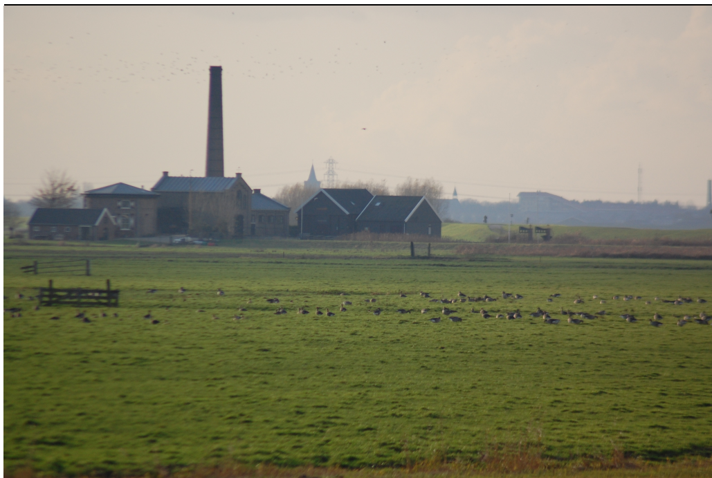
Figuur 4.3 Stoomgemaal Hertog Reijnout
