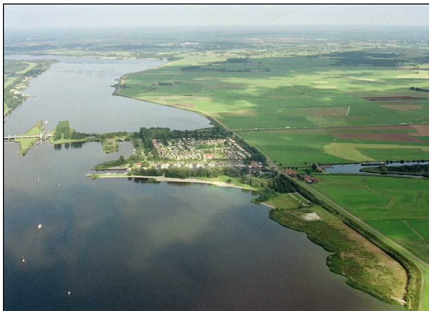
Afbeelding 3.4: Luchtfoto Nieuw Hulckesteijn en de Nijkerkersluis
