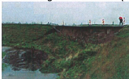
afbeelding 1.4. Macrostabiliteit binnenwaarts (links) en afschuiving van binnentalud (rechts)
