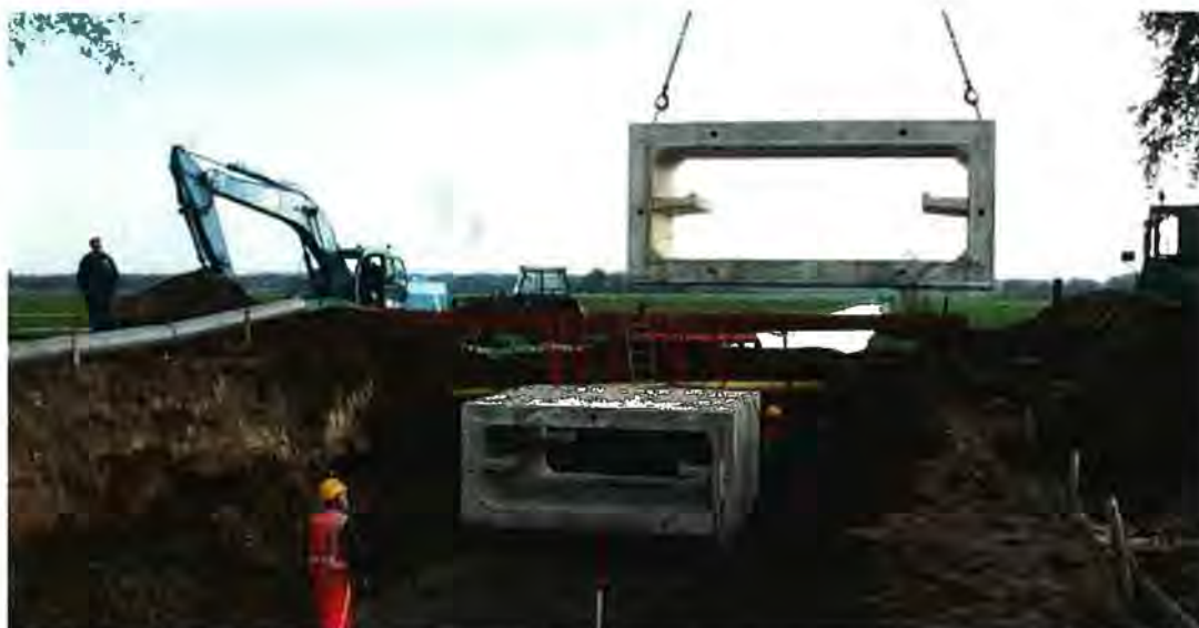
Figuur 6.12: Voorbeeld van een hier toepasbare eco-duiker.
