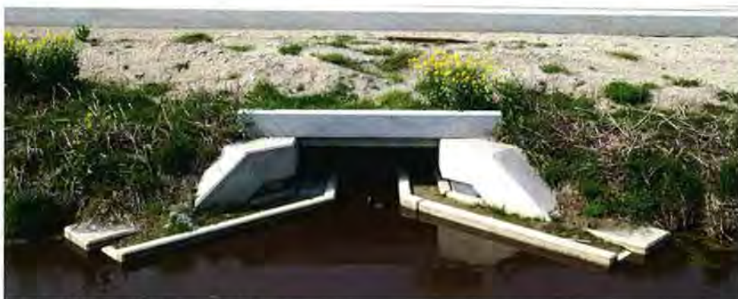
Figuur 6.45: Een klein type ecoduiker.
