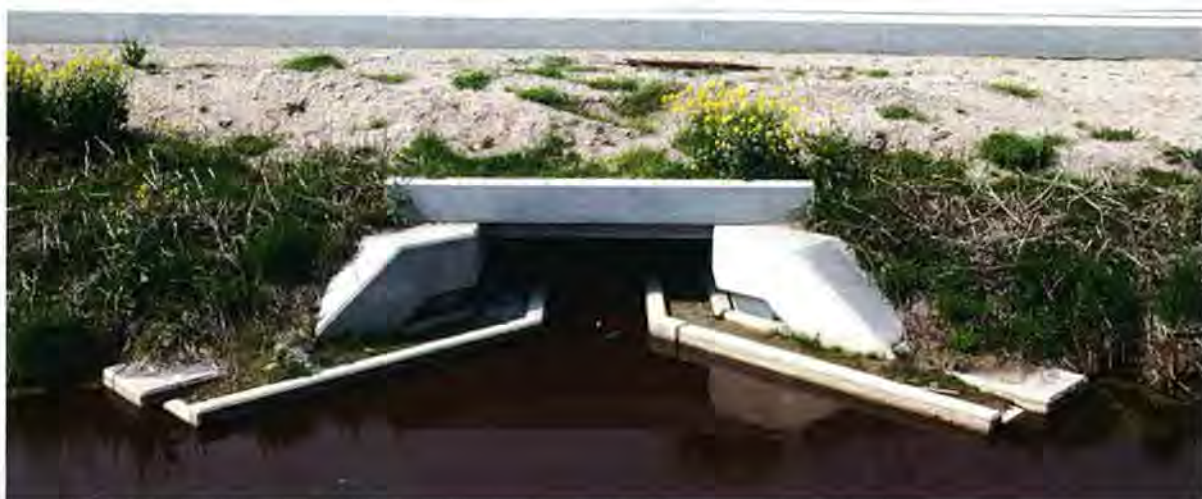
Figuur 6.11: Voorbeeld van een klein type ecoduiker met loopstrook.
