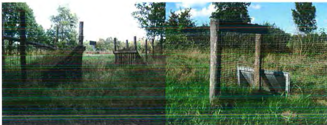
Figuur 6.10: Terugkeervoorzieningen; links een inspringvoorziening bij een Reeënraaster (Ree-insprong), rechts een terugkeerluik voor in een Dassenraaster.
