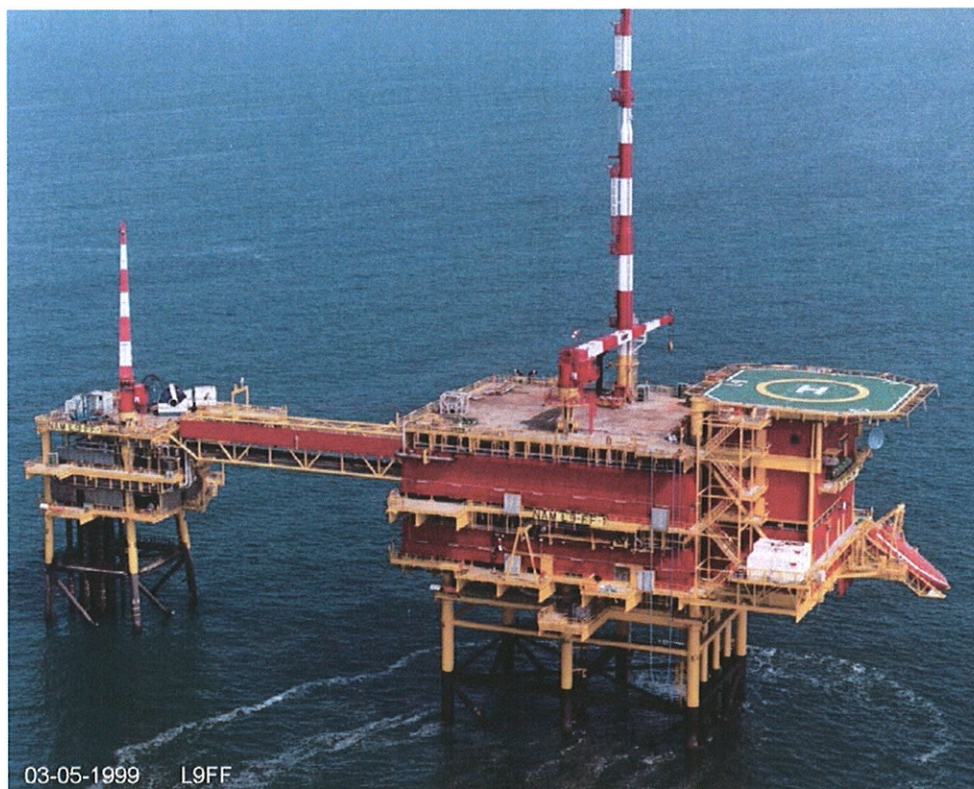
Figuur 3.2 Foto van het bestaande behandelingsplatform L09-FF-1.
