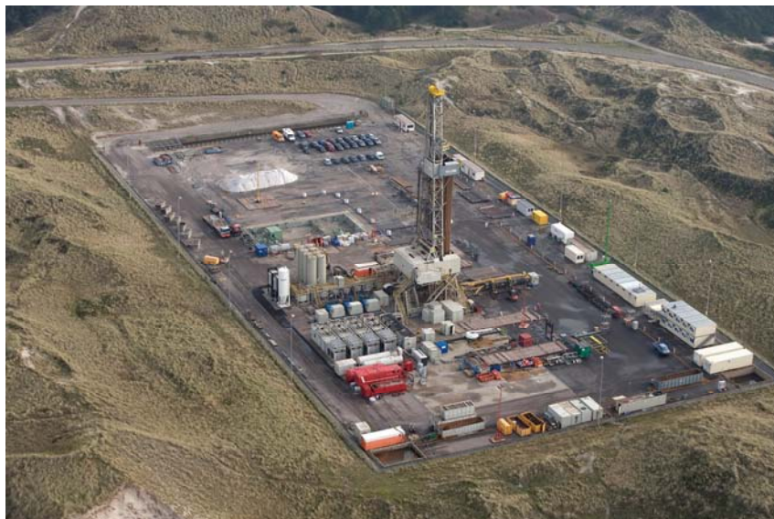
Figuur 4.4-1: Impressie van een landboorinstallatie met faciliteiten in de duinen bij Groet
