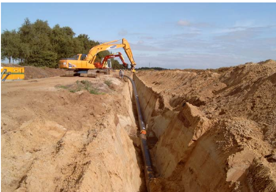
Figuur 4.6-2: Aanleg van transportleiding met open ontgraving
