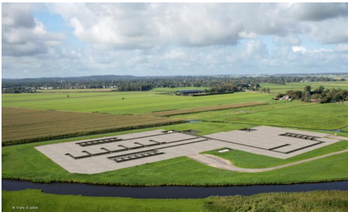
Figuur 4.3-2: De huidige situatie van de BGM (eerste foto) en een artist impression van het terrein naar afloop van de boringen en afwerking
