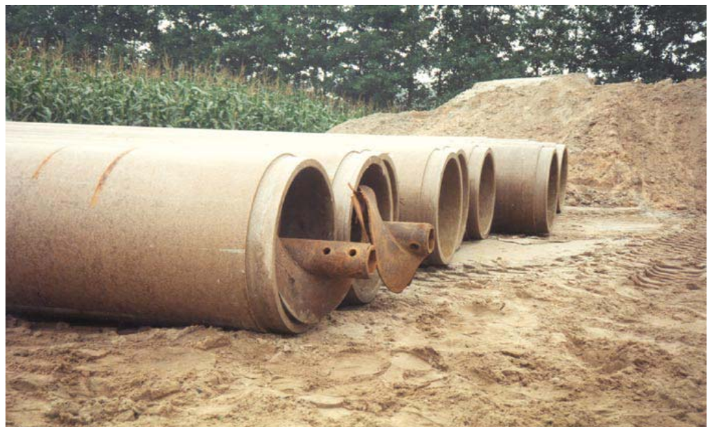
Figuur 8. Buisen met avegaar (grondboor) voor grondafvoer.
