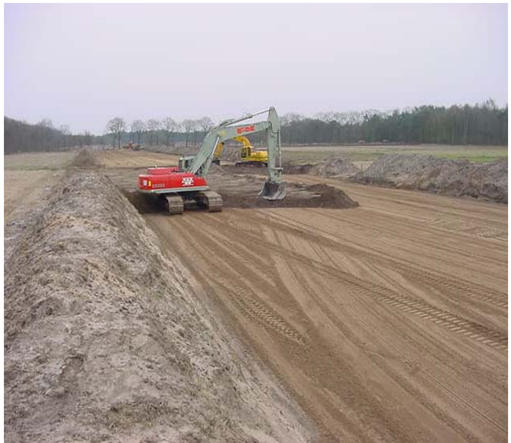
Figuur 5. Terugzetten teelaarde.
