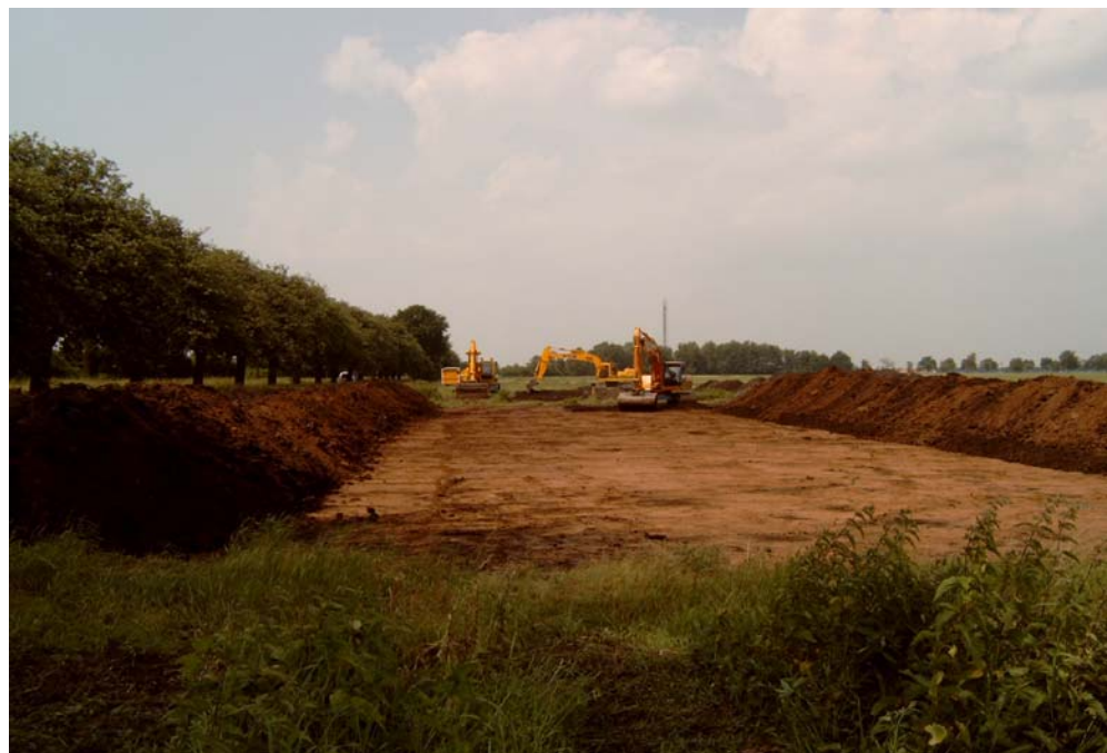
Figuur 2. Ontgraven teelaarde.
