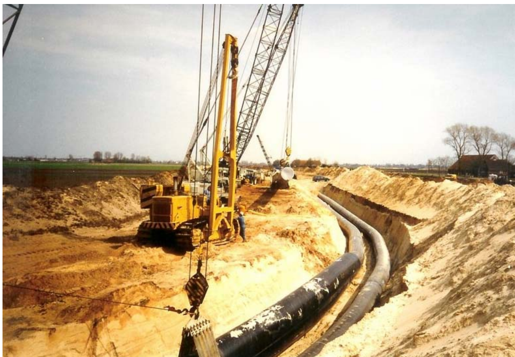
Figuur 4. Leggen van leidingen in sleuf.
