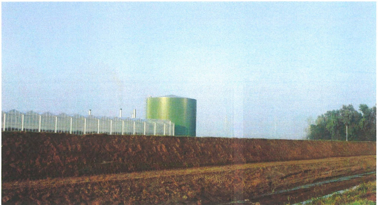
Figuur: De elektracombinatie voor de komende decennia. Kas met warmtebuffer en WKK's en windmolens op de achtergrond (zie ook: Energieraad, brandstofmix in beweging, januari 2008).
