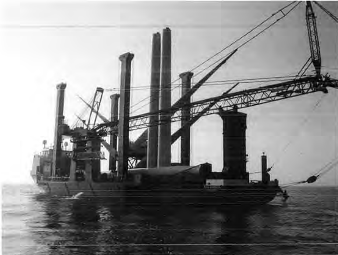
Afbeelding 3-2 Installatie turbine (bron: windpark Prinses Amalia)
