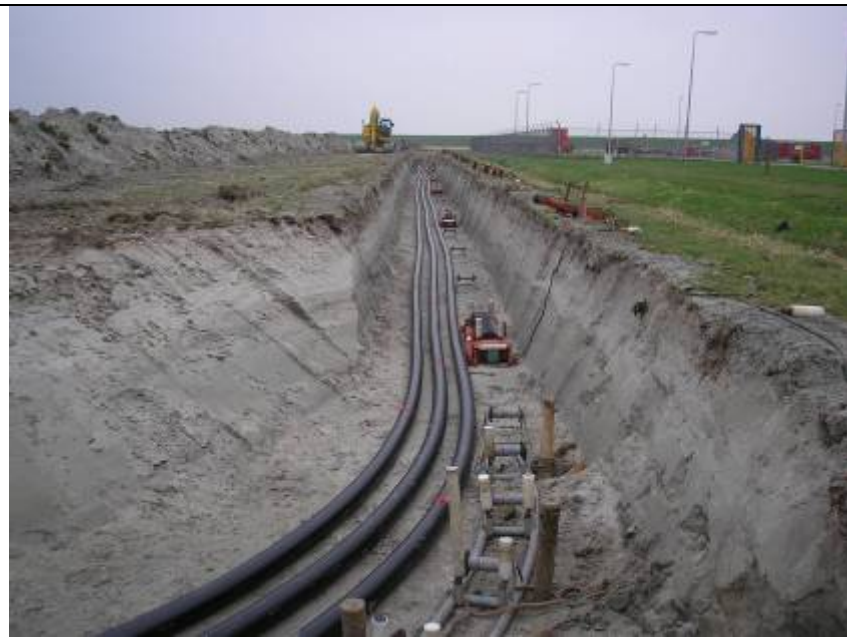
Figuur 6.2 Aanlegwerkzaamheden voor ondergrondse kabels
