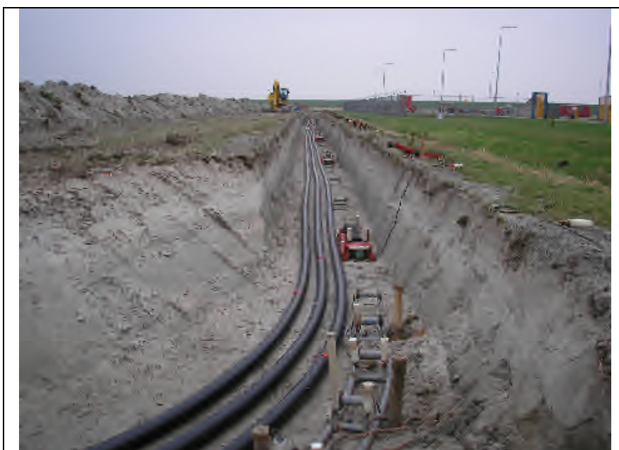
Figuur 5.2 Aanlegwerkzaamheden voor ondergrondse kabels
